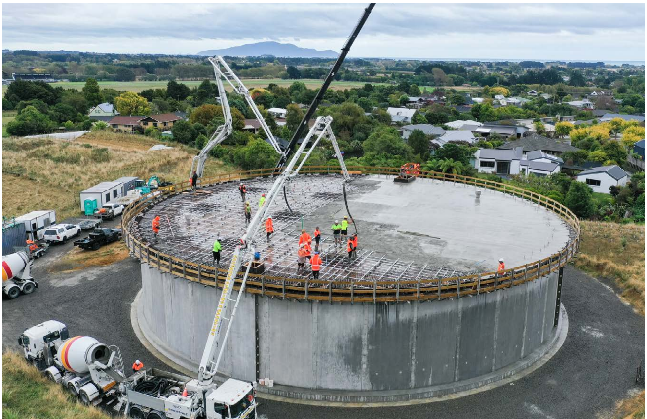
Ōtaki reservoir roof pour.
